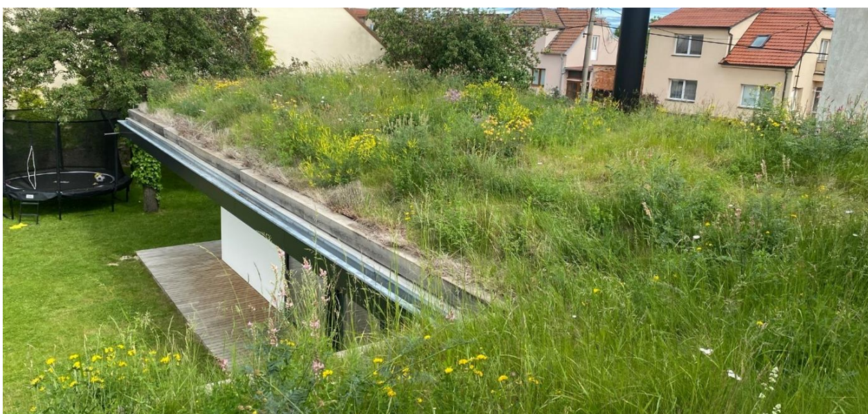
Obr. 30: Polointenzivní střecha Soběšice (luční společenstva)
