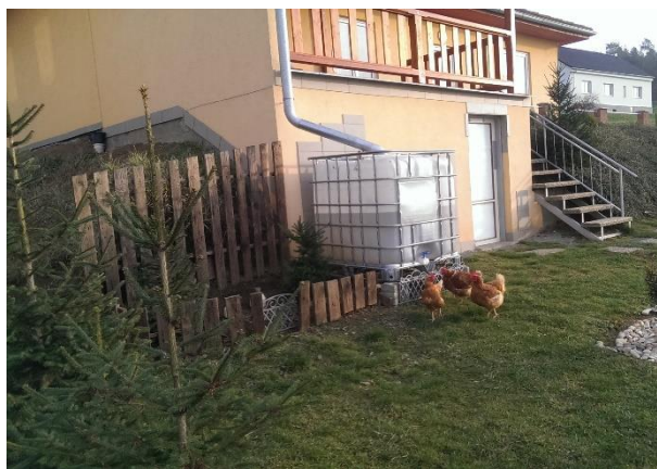
Obr. 36: Klasická střecha a akumulční nádrž (nadzemní)
