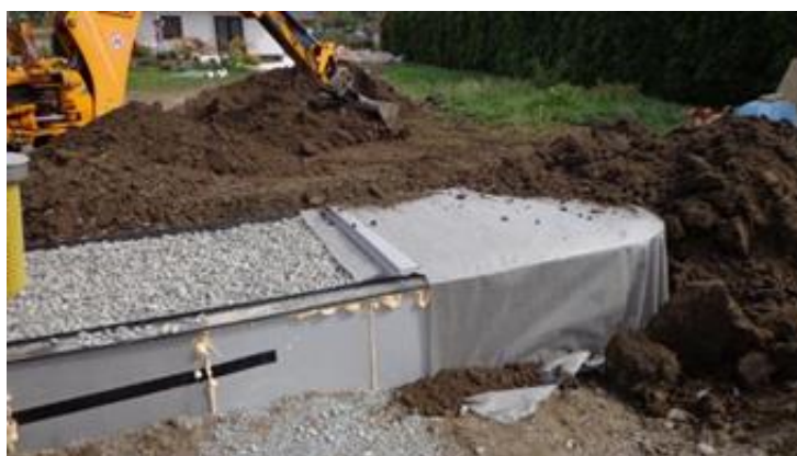
Obr. 19: Příklad semicentrálního řešení čištění a zasakování vyčištěných šedých vod
