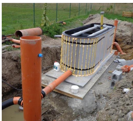
Obr. 19: Příklad semicentrálního řešení čištění a zasakování vyčištěných šedých vod
