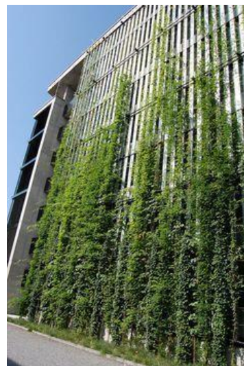
Obr. 38: Pnucí vegetace na konstrukci Sihl City v Curychu
