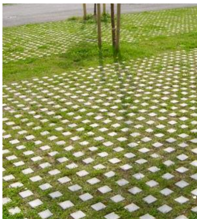
Obr. 45: Betonové bloky zatravnňovací
