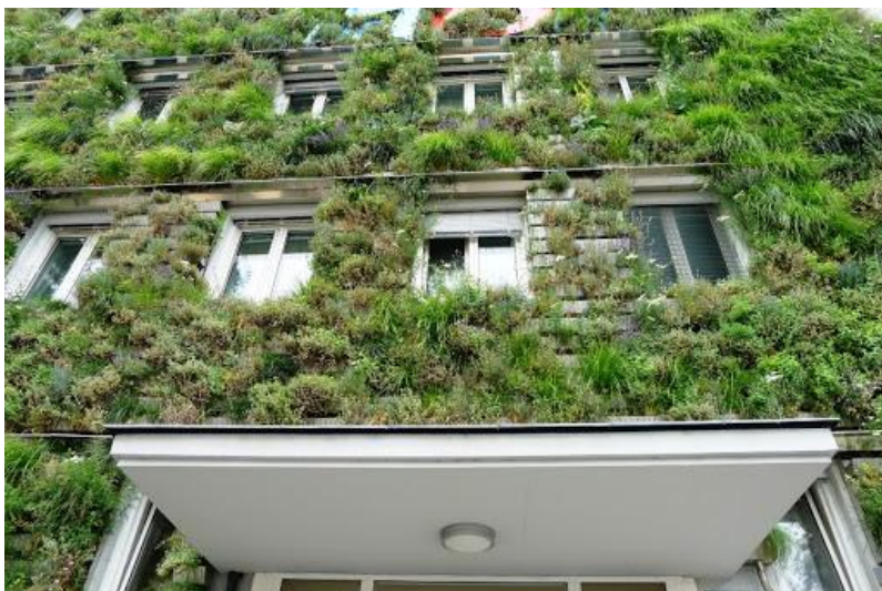
Obr. 37: Vegetační fasáda Einsiedlergasse ve Vídni
