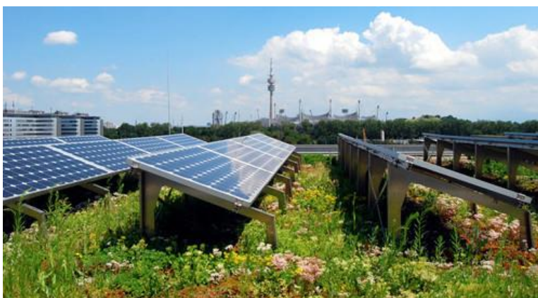
Obr. 31: Extenzivní střecha v kombinaci s fotovoltaikou
