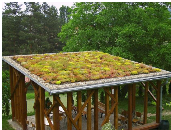
Obr. 29: Extenzivní střecha ZŠ Heyrovského
