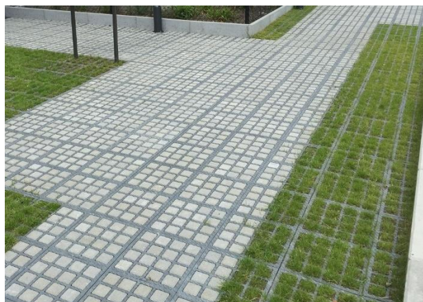
Obr. 41: Příklad zatravnňovacího roštu z recyklovaného plastu
