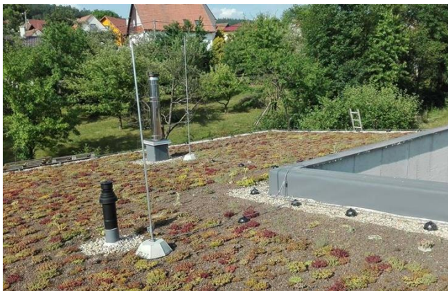
Obr. 28: Extenzivní (rozchodníková) střecha
